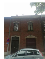
Avenue Jules Destrée 60, MONCEAU-SUR-SAMBRE
