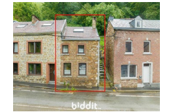
Rue aux Usines 310, NESSONVAUX PEB
