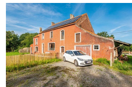
Rue du Moulin d'Hollers 2, VILLERS-LA-VILLE
