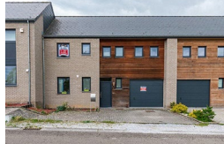
Rue du Québec 5, CERFONTAINE
