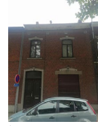
Avenue Jules Destrée 60, MONCEAU-SUR-SAMBRE
