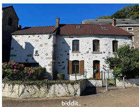
Rue du Rivage 15, ANNEVOIE-ROUILLON
