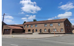
Rue du Pont de la Cure 10-16, LEUZE-EN-HAINAUT
